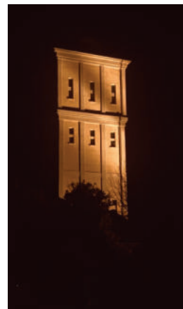
Wasserturm bei Nacht
